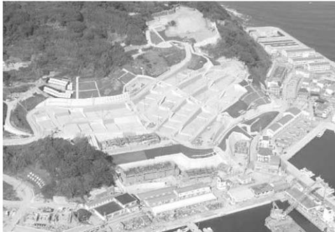
現在の工事状況(平成19年10月21日撮影)
