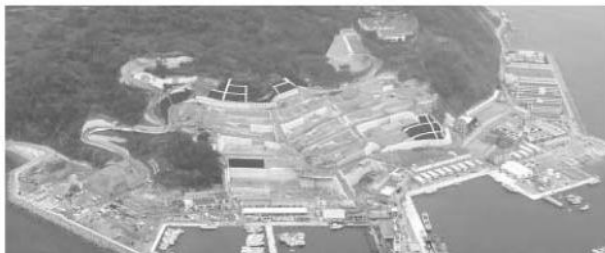
現在の工事状況 (平成 19 年 6 月 17 日撮影)
