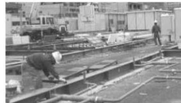
仮設住宅の解体が進むかもめ広場
