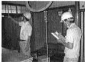
建物調査の様子
