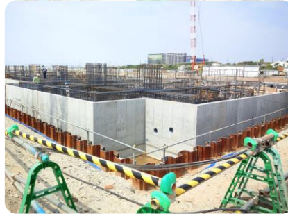
基礎工事の様子
