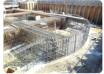
鉄筋工事の様子
