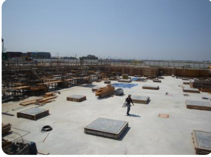
免震装置設置前の様子
