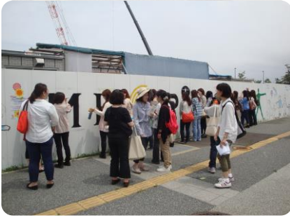
仮囲い設置状況 (こども病院/新採用看護師研修にて)
