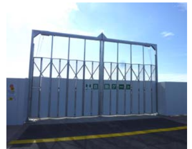
工事車両出入口
