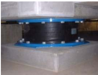
天然ゴム系積層ゴム 設置状況
