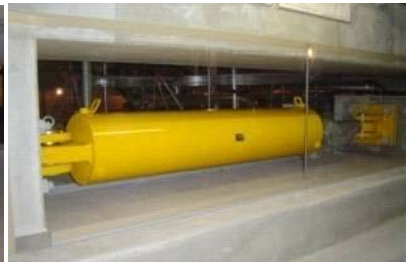
オイルダンパー設置状況
