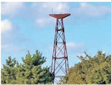
ロープウェイの支柱跡
