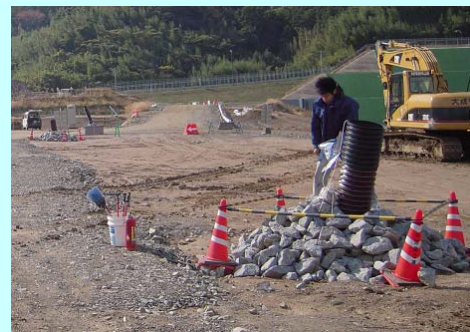
埋立場の発生ガス調査
