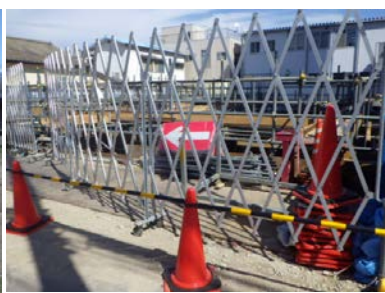
10階建ビルの基礎工事
