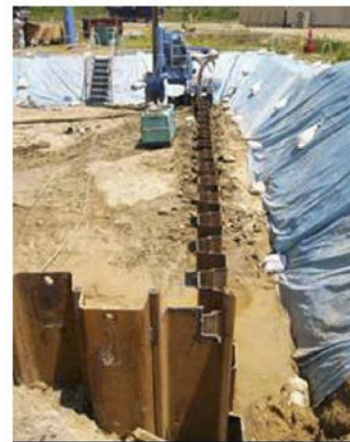
図 8-20 遮水壁（鋼矢板）の打設状況
