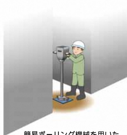
簡易ボーリング機械を用いた観測井設置状況
