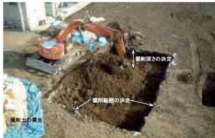
図 8-14 掘削除去の概況写真
