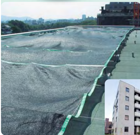
屋上の遮光ネット
