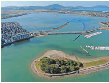
今津橋を上空から撮影した風景
