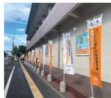
鴨池公園プール壁面
