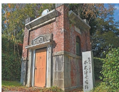
配水池の点検用通路入口
