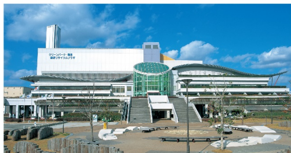
清掃工場（ごみ焼却場）
