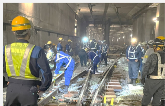
[参考] 夜間工事 (分岐器更新工事)
