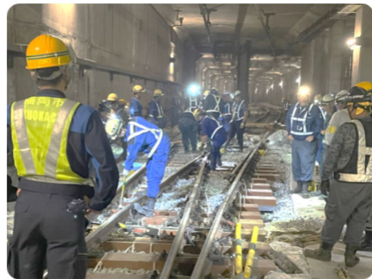
(参考) 夜間工事 (分岐器更新工事)
