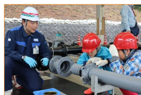
水道管の接合
