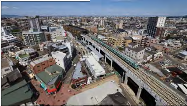
雑餉隈高架駅と高架橋
