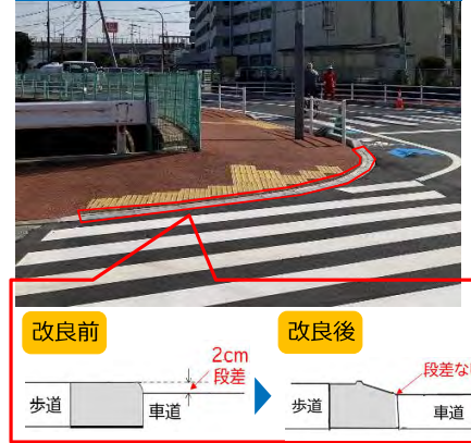
段差のない縁石の整備事例 (老岐団地)
