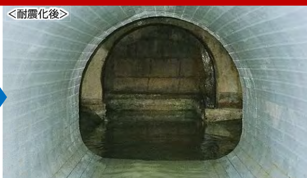
下水道施設の耐震化【幹線管渠】
