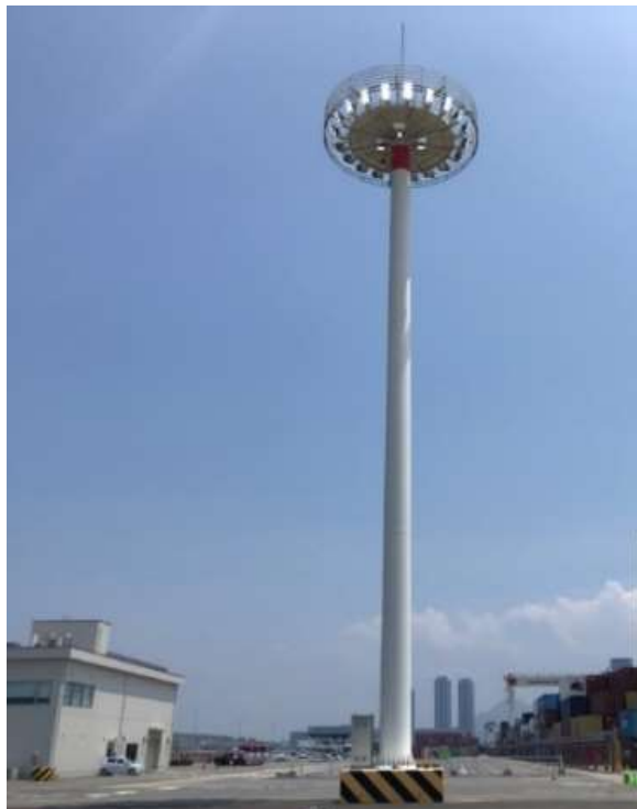
コンテナヤード照明のLED化
