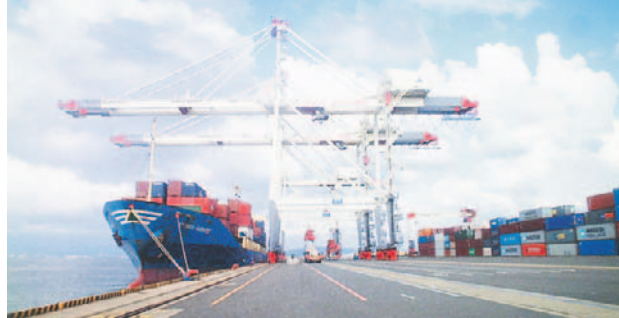
来年4月にはコンテナクレーン2基を設置。計5基が稼働するようになる
