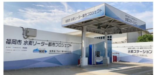
水素ステーション（中部水処理センター）
