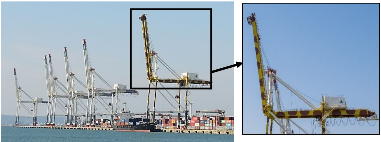
▲キリン柄のコンテナクレーン
