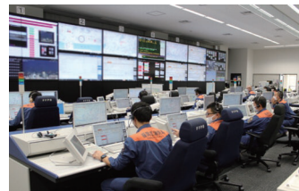
福岡都市圏 消防共同指令センター
