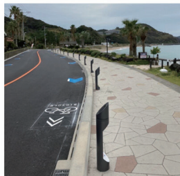
北崎地区の道路整備状況
