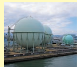
ガス貯蔵タンク
