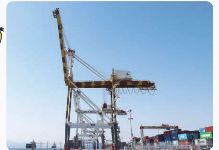
アイランドシティのコンテナクレーン
