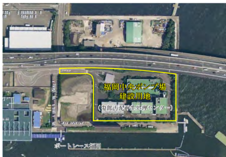
福岡中央ポンプ場建設用地の概要
