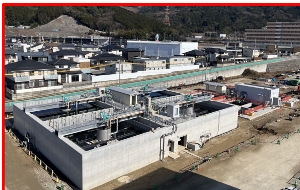
④ 洗浄排水池、排泥池、濃縮槽
