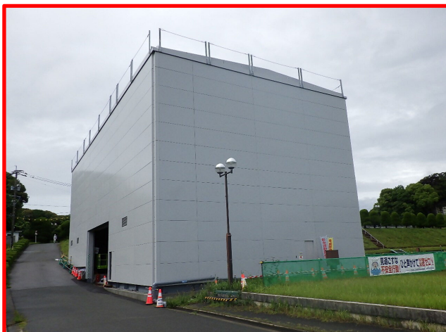
① 発進立坑（防音ハウス）
