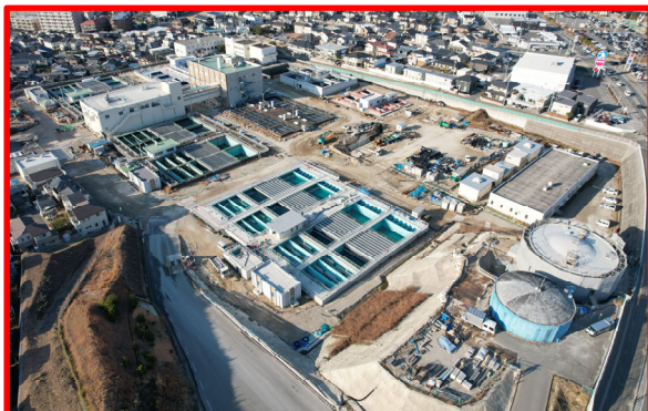
乙金浄水場 全景
