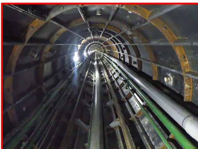
② セグメント設置（内径 1350mm）
