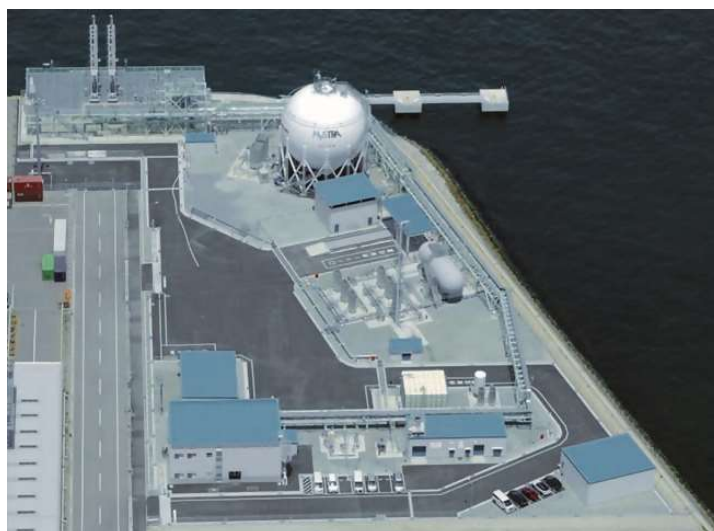
図6 水素の受入・供給施設（神戸港事例）
