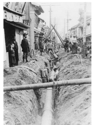
④ 博多部の配水管布設
