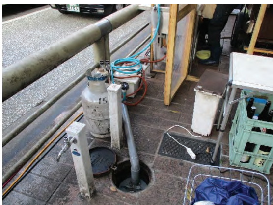
(写真①) 接続状況
