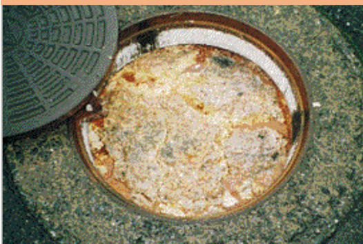
マンホールへ流出した油脂
