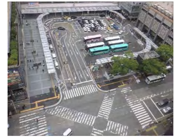
博多駅筑紫口駅前広場
