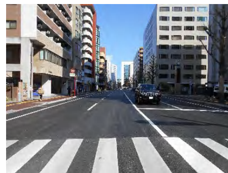
御供所井尻3号線（祇園大通り）（事業後）
