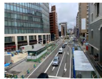
地下鉄七隈線新駅地下駐輪場
