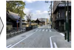
御供所町297号線外(御供所通り)(事業後)
