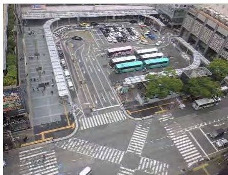
博多駅筑紫口駅前広場（事業後）
